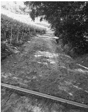
Talweg im Graben, Entwässerungsrigole
