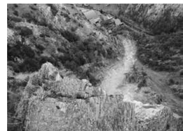
Sicht von Abbruchstelle auf Transit- und Ablagerungsbereich (Sägerei Zanella unterhalb Schutzdamm)
